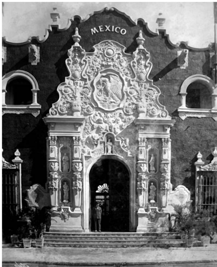
Fachada del pabellón de México en Río de Janeiro, Brasil, demolido en 1925. (Fuente: Díaz, Lourdes. Alberto J. Pani, promotor de la arquitectura en México, 1916-1955 , Tesis para obtener el grado de Doctor en Historia del Arte, México, UNAM, 2009, p.223)
