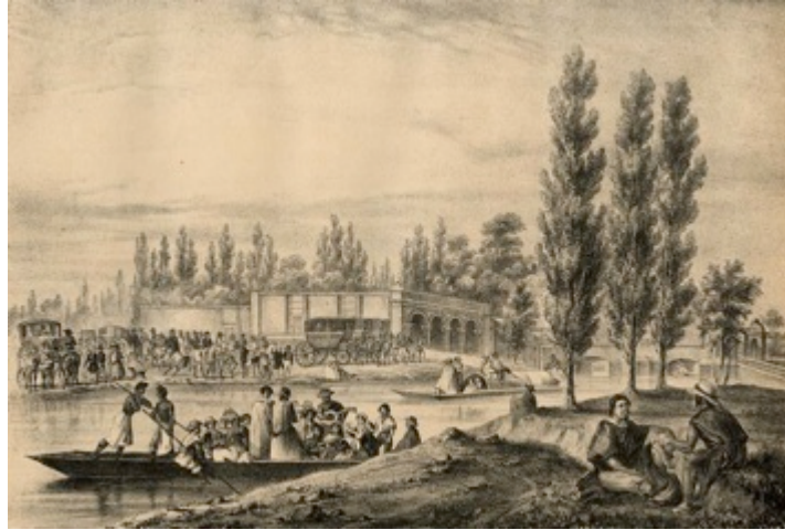
Paseo de la Viga en México Nebel C., 1963. Lam.5
